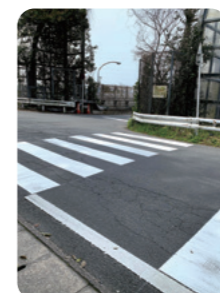
横断歩道の補修
